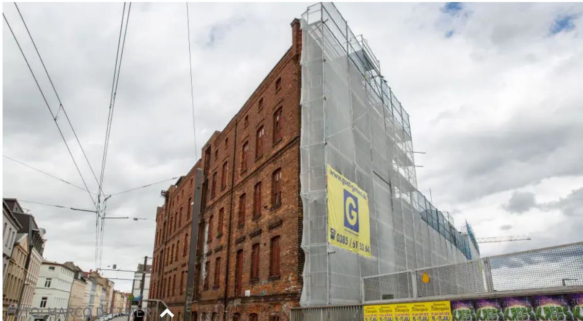
Die Bahnseilung nutzen die Projektleiter, um ein Baugerüst aufzustellen
